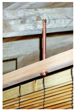
ビス留め施工の写真です。
