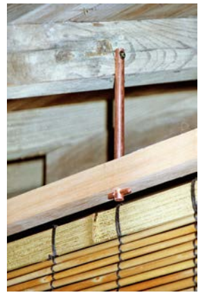
ビス留め施工の写真です。
