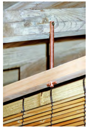
ビス留め施工の写真です。
